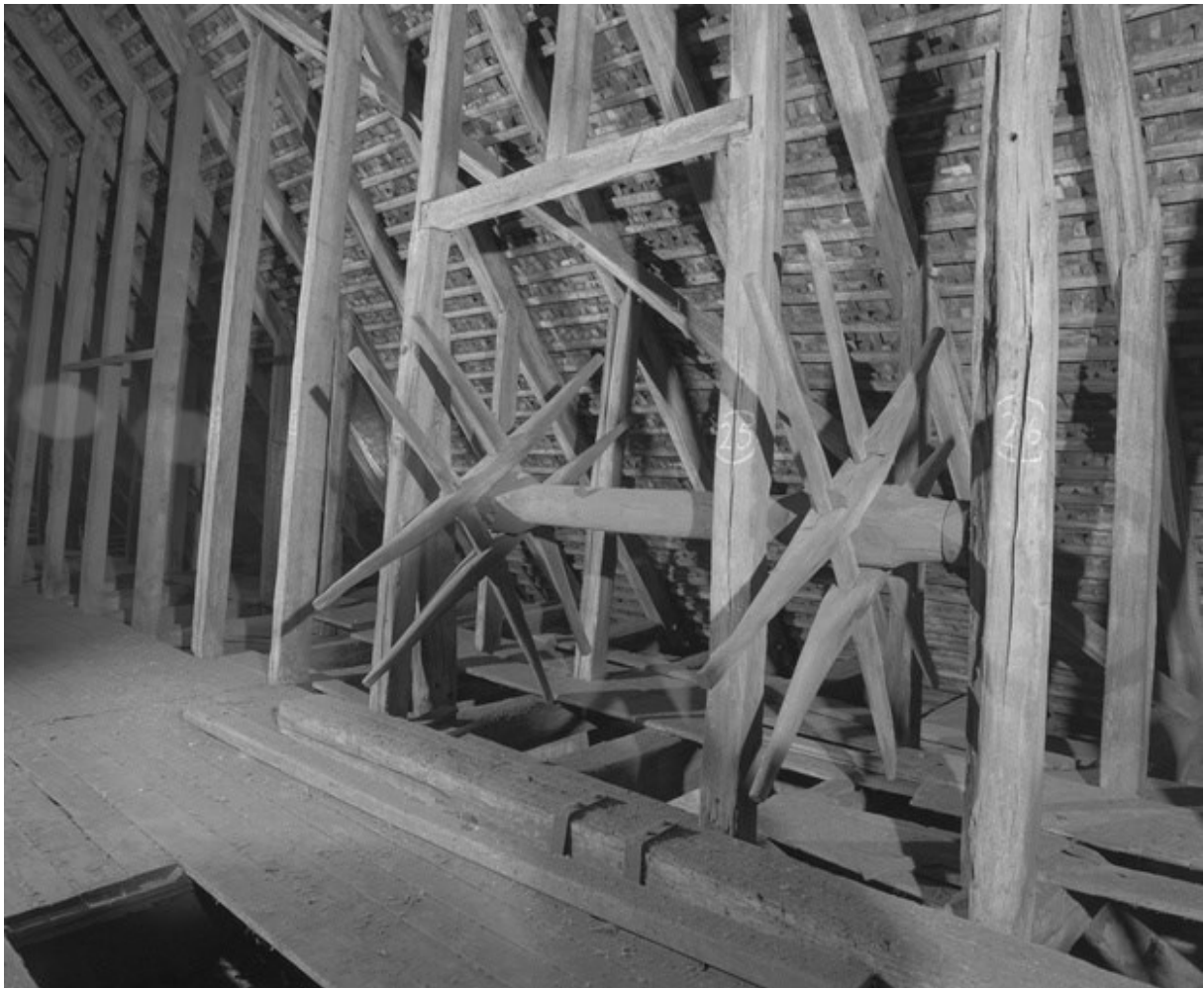
Saint-Georges - Vue du treuil fixe dans la charpente et l'ouverture.
