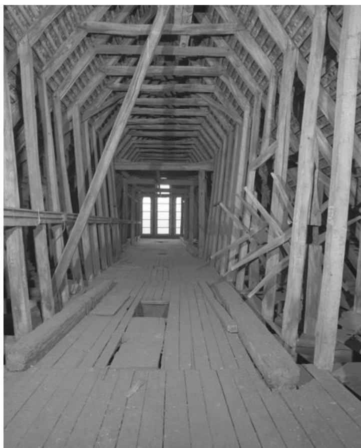
Saint-Georges - Charpente de la nef vue d'ensemble vers l'ouest.
